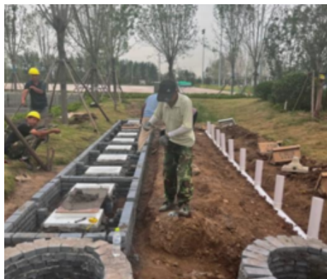
现场施工进度
