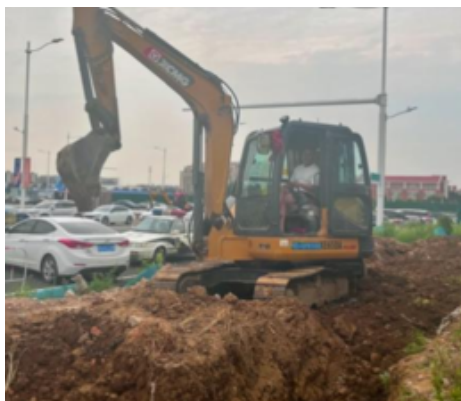
机械进场施工
